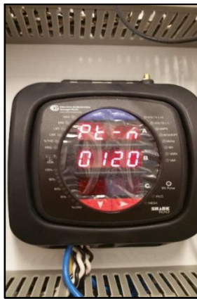
Fig. 4 Shark 100 Energy Meter
